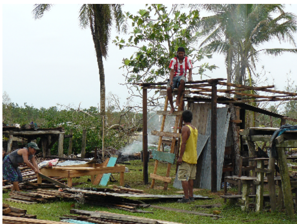
Aufräumungsarbeiten nach dem Hurrikan Mitch
